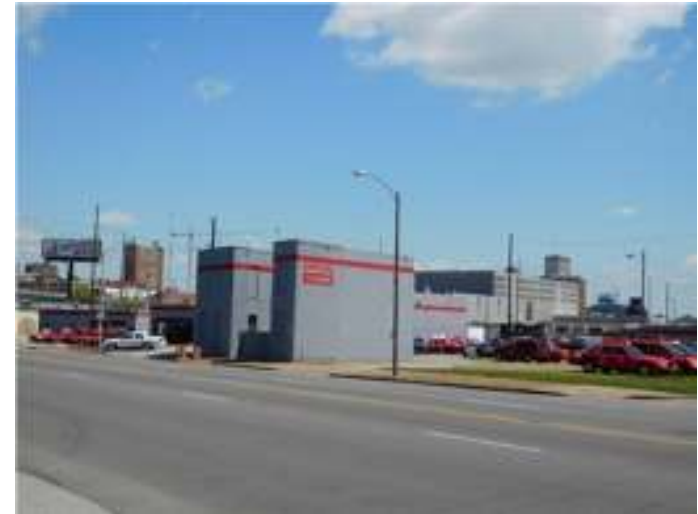
Laclede Cab Co. complex, Vandeventer Ave.
